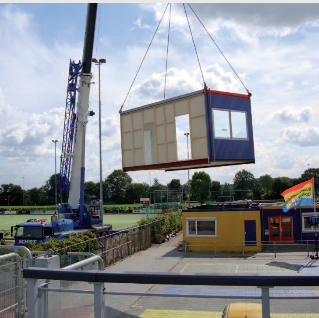
Een fotoimpressie van het plaatsen van de uitbreiding
